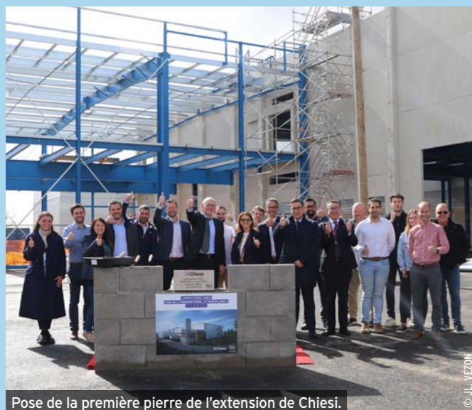
Pose de la première pierre de l'extension de Chiesi.
