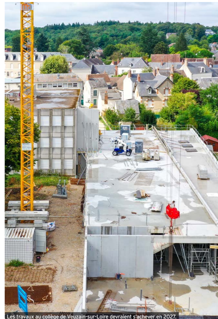
Les travaux au collège de Veuzain-sur-Loire devraient s'achever en 2027.
